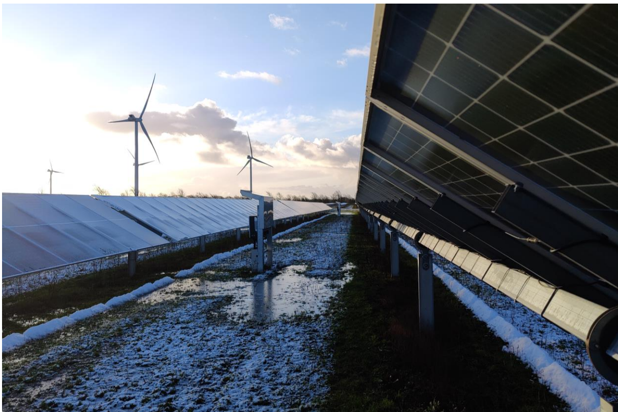
Eksempel på trackingsystem med bi-facial solcellemoduler
